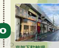
高架下駐輪場外部手すり部分
