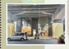
高架下の左右柱に設置してあるパネルを利用
